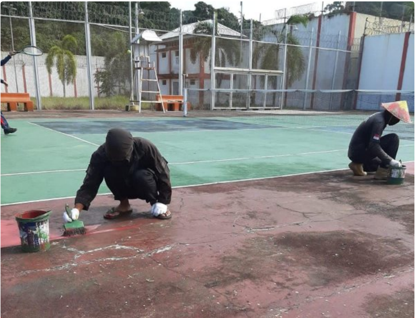
Lapas Pasir Putih Gelar Kegiatan Perawatan Gedung dan Bangunan Lapas
